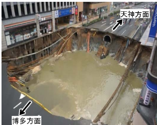
[陥没状況写真]
